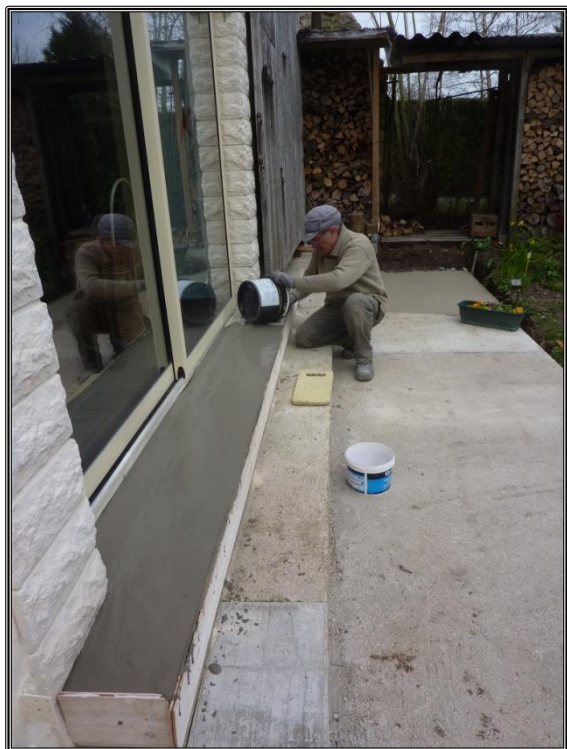
Ragréage de la marche devant la baie vitrée
