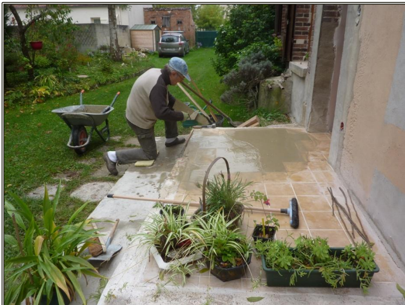
Ragréage et mise à niveau avant la pose finale.
