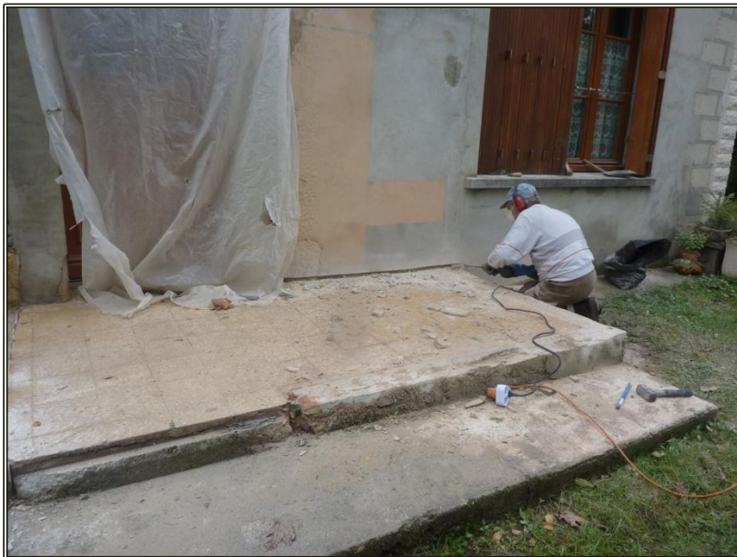
Réalisation du rainurage pour câblage électrique
