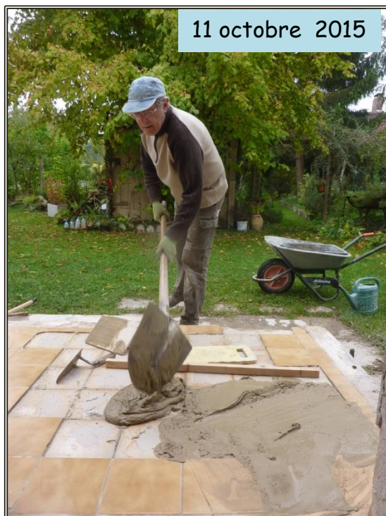
Dépose d'une partie du carrelage instable
